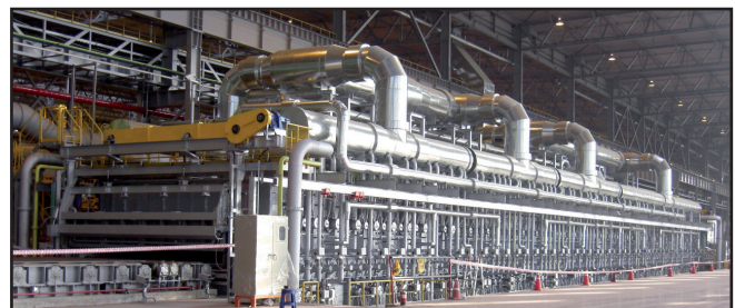
Rollenherdofen für Grobblech mit RECUFIRE®-Strahlheizrohren Печь с роликовым подом для толстолистовой стали с излучающими трубами RECUFIRE® by courtesy of HANWHA TechM
